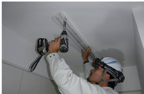
建設電気設備 照明器具取付状況
